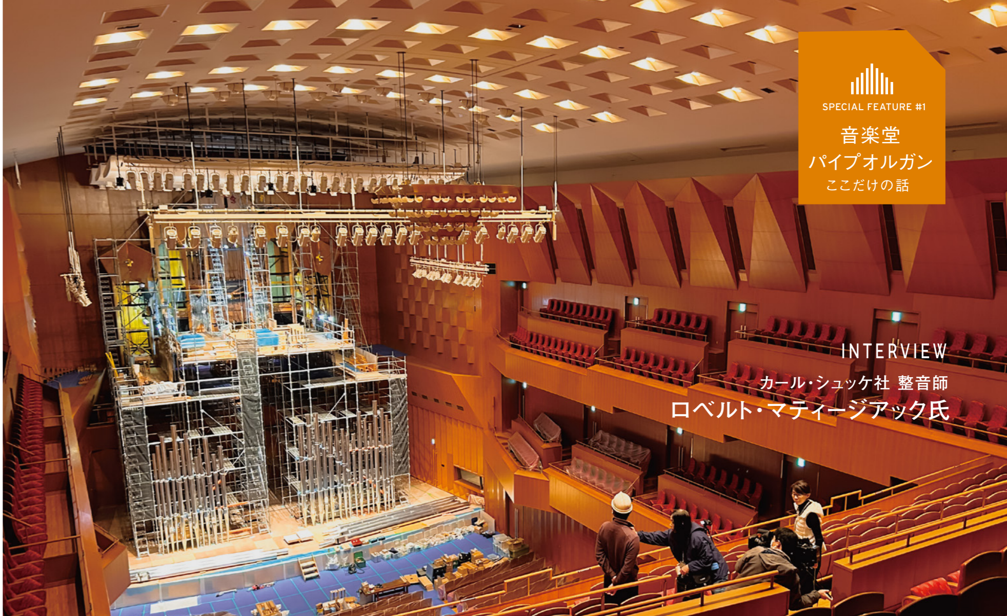
▲改修中のパイプオルガン (2025年12月撮影)
